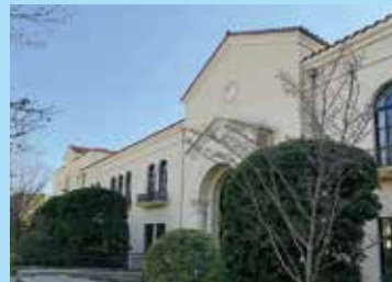
⑨G号館玄関前
